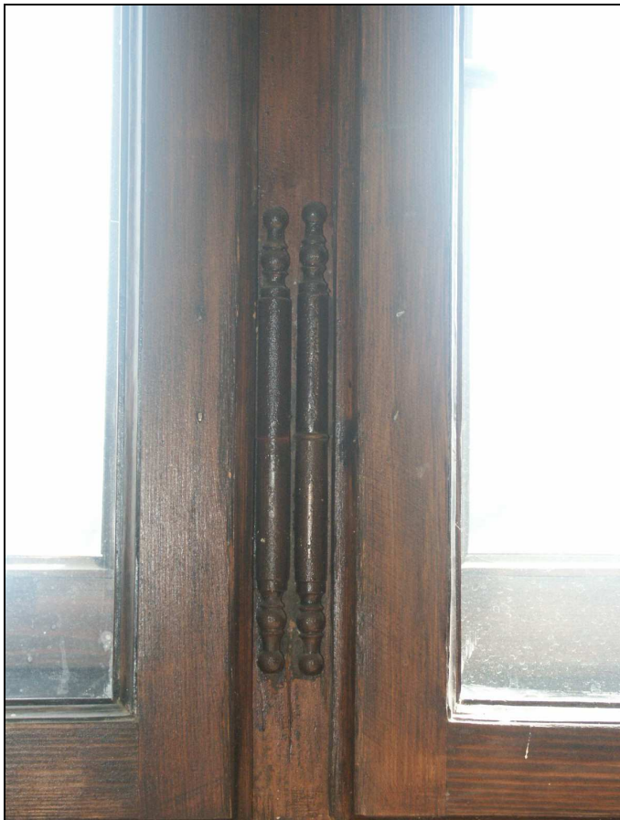
původní okenní závěsy s kuželkovými konci
